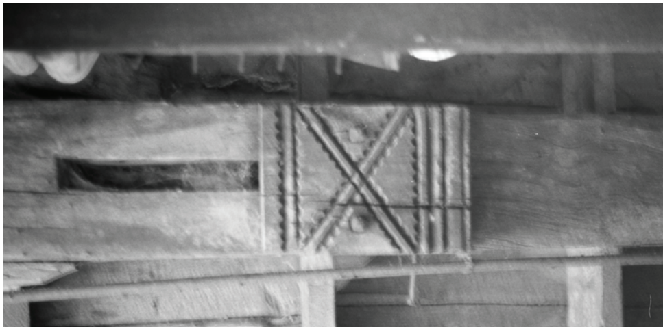
63. Bewerkt 'los' sleutelstuk met gesmede of 'taai' nagels, Goorestraat 1. BHIC
