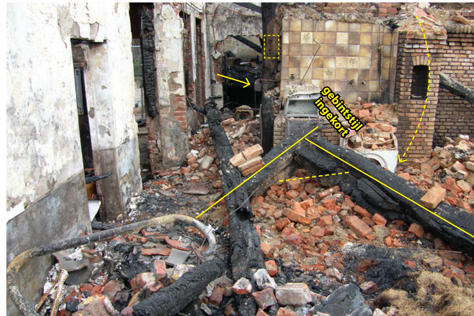
41. Het voorgeplaatste lage gebint na destructie. In de muur het gebint op stramien 3. Daarin zijn de stalen strip te zien waarmee beide gebinten aan elkaar verbonden waren. In het aangeduide vierkant is het bouwspoor aangemerkt dat duidt op een horizontale koppelbalk. D. Bol
