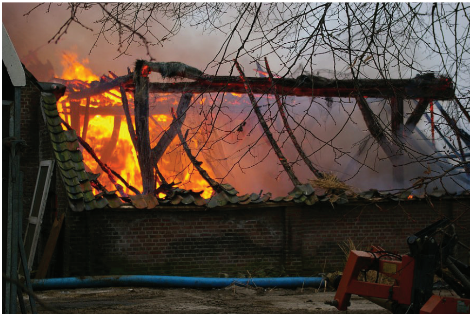
38. Door het ingevallen dak van het schuurgedeelte is het hergebruikte Vlaamse gebint totaal te zien. Brabants Centrum / Gerard Schalkx
