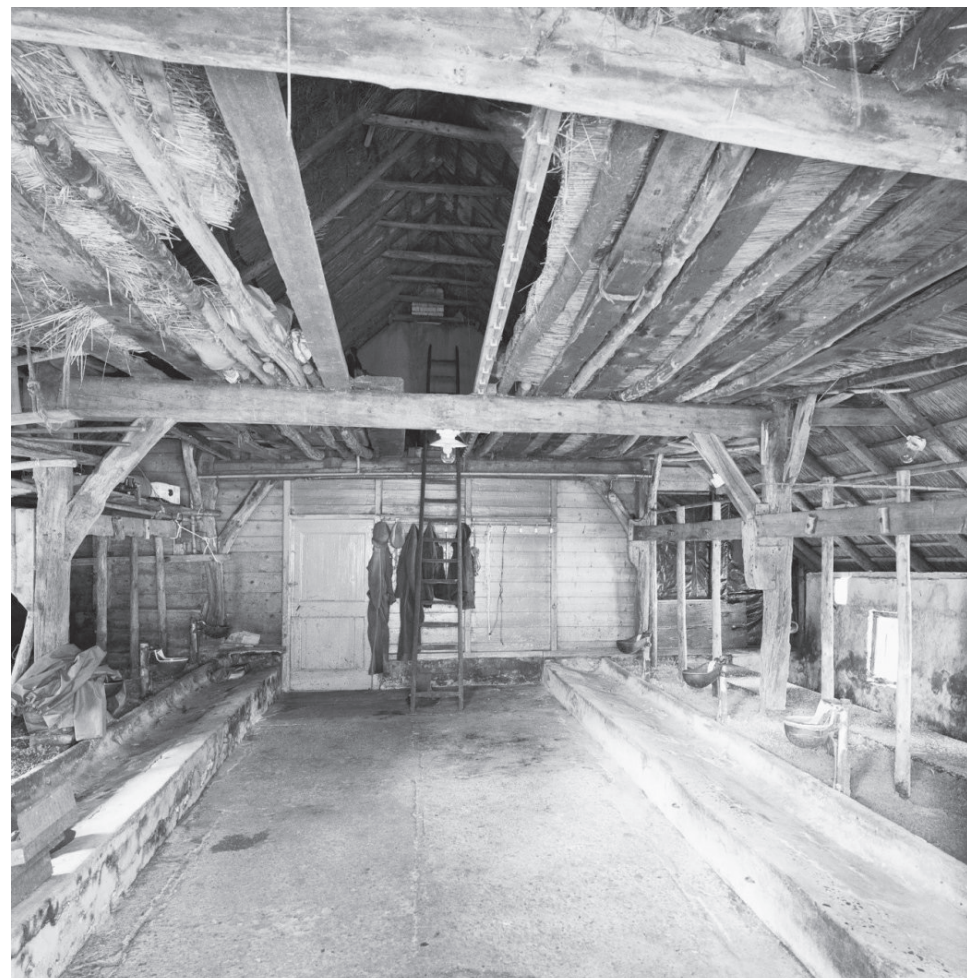
76. Interieur van de middenlangsdeel van een hallenhuisboerderij in Zwartsluis. De koeien stonden in de lagere zijbeuken (1997). P 50 Monumenten in Nederland. Overijssel, R. Stenvert e.a. 1998 RCE.
