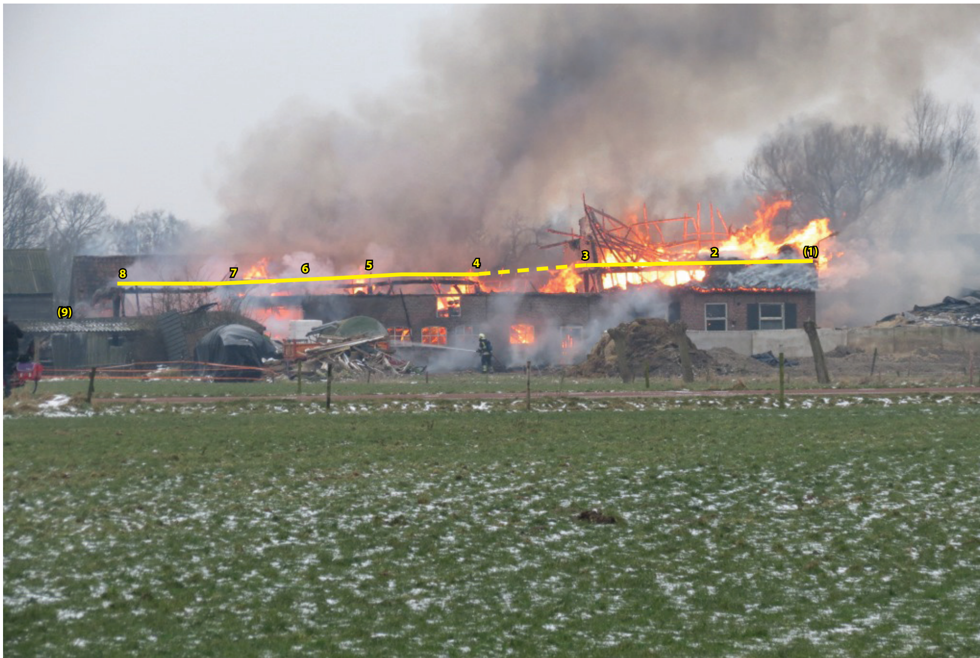
35. Tijdens de brand kwam het hele gebint vrij te liggen. Van de langspaat is een deel tussen de lussen weggefallen. Met nummers zijn de stramienien waarop de gebintstijlen staan aangeduid. Brabant Centrum, Ad Ligtenberg.
