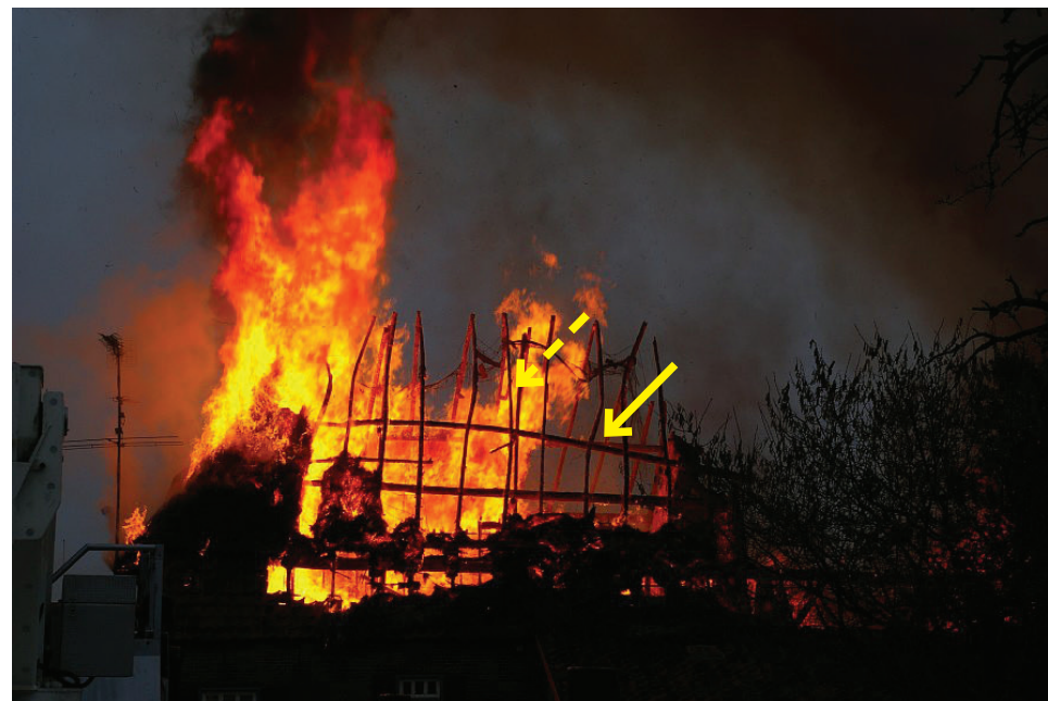
37. De gekoppelde daksporen met horizontale hanebalken (gestippelde pijl) werden naast de oude langsplaat ondersteund door flieren (gele pijl).
