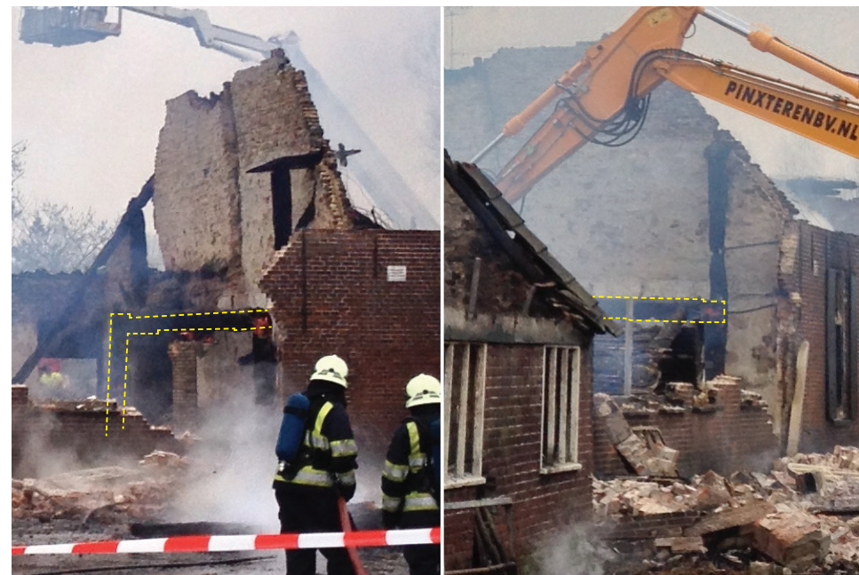
48. Twee zichten op de twee gebinten op stramien 3. Op de rechter foto zien we de koppeling door ankers met de buitenmuur. Van de laag geplaatste balk (stippellijn) is de pen te zien waarmee de balk aan een gebintstijl bevestigd is geweest. Die gebintstijl is niet meer aanwezig.
