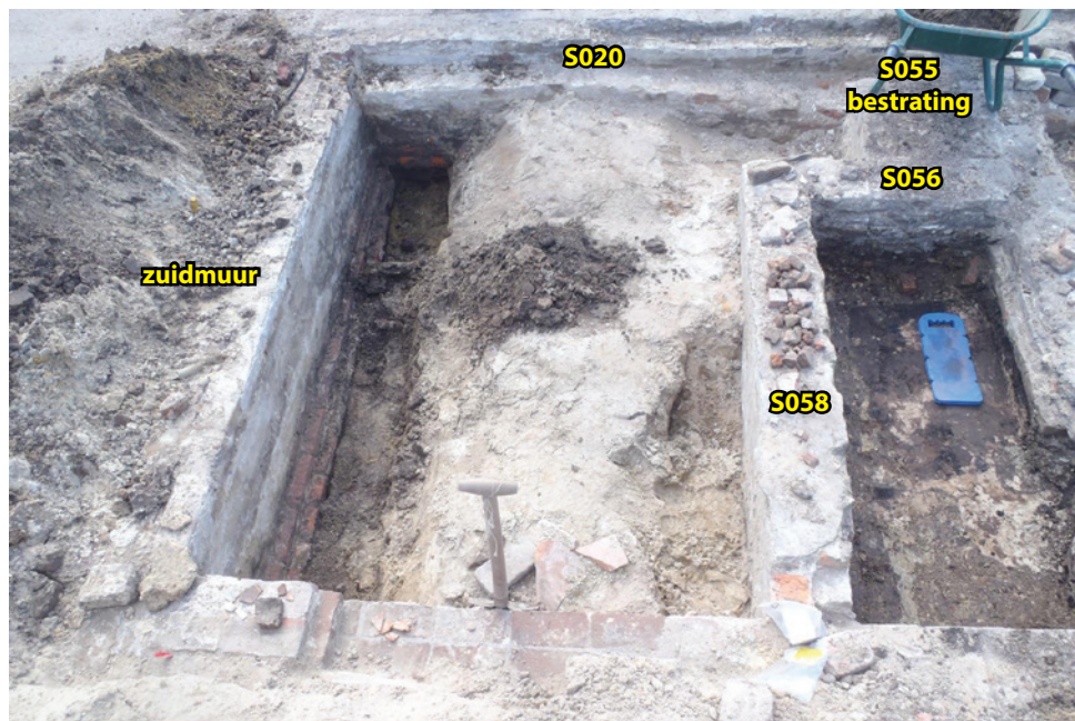
59. De kleine muurtjes (S056-58) zorgen nog altijd voor een raadsel. De muren zijn door een situering waarbij de ene fundering de andere kruist vermoedelijk van de verbouwing uit 1892. De functie is onduidelijk. Heemkunde Boxtel 2015.
