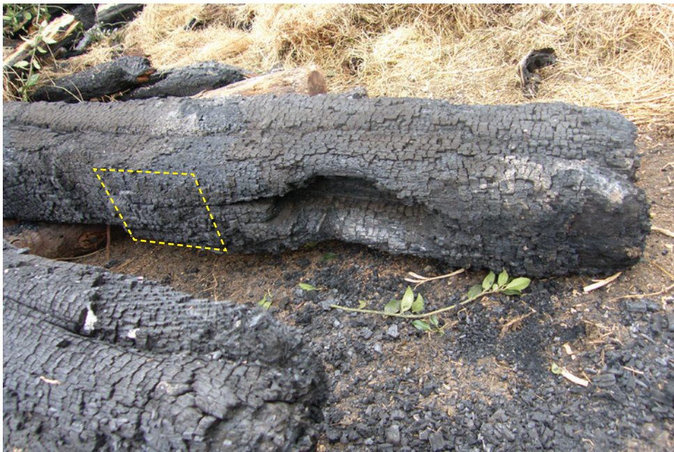
43. Aan de verzwaaring bij het uiteinde van de balken zijn de oude sleutelstukken te herkennen. Het gat was de verbinding met de korbeel. het bewerkte gedeelte moet gezeten hebben ter plaatse vande aanduiding in geel. D. Bol
