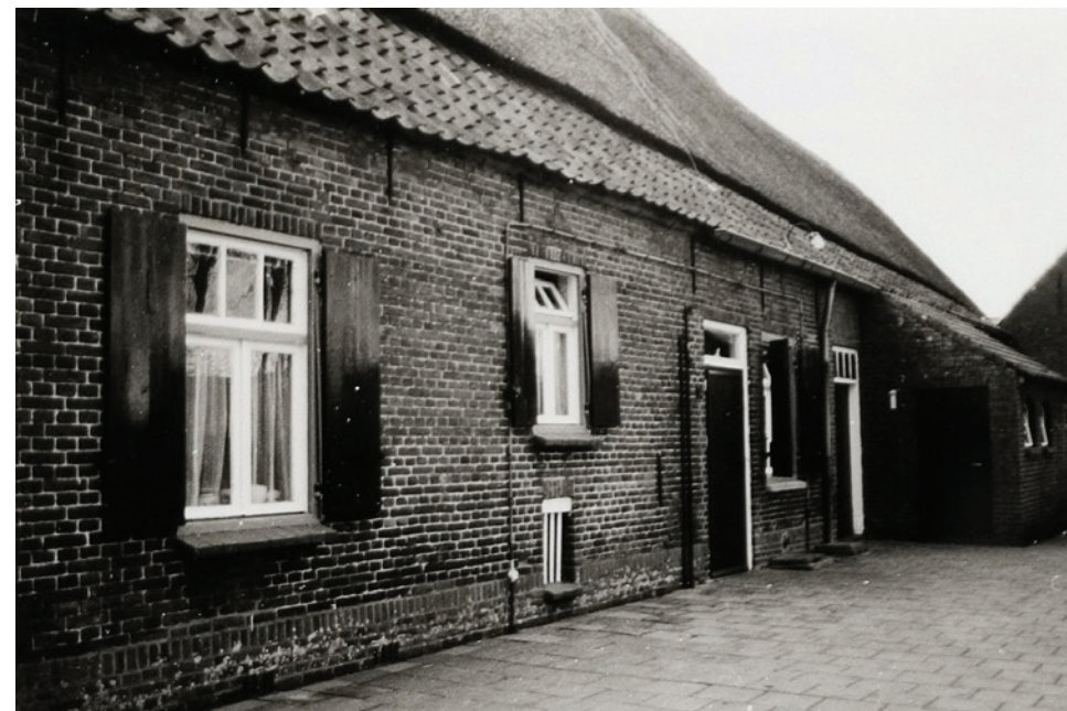
30. Zicht op de straatgevel van de Kartuizerhoeve in 1980. Het oude kozijn (rechts) is opgenomen in jonger metselwerk. Provincie Noord-Brabant.
