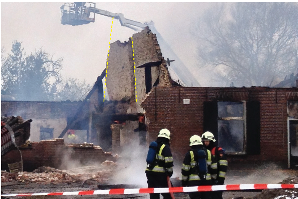
39. Tegen de brandmuur zijn de laatste resten van het gebint te zien. Rechtsboven steekt de langsplaat door de brandmuur. Het rookkanaal van de schouw is afzonderlijk leesbaar in de brandmuur (gele stippellijn).
