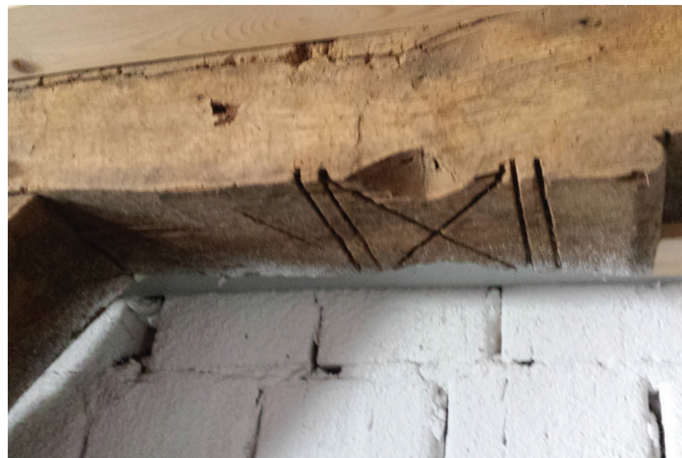
69. Detail van moerbalk met sleutelstuk uit boerderij Hoolstraat 12, Nuland (1593 dendrochronologisch onderzoek), P. Schamp / J. Bertens 2015
