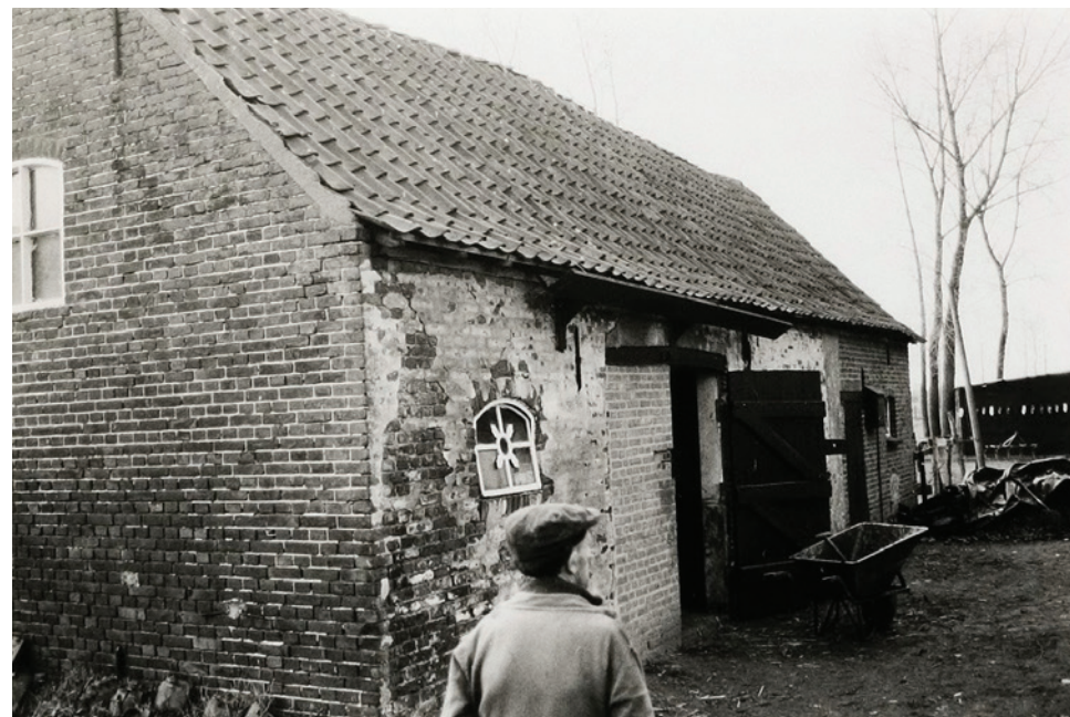
15. Het bijgebouw naast het bakhuis in 1980. Provincie Noord-Brabant.
