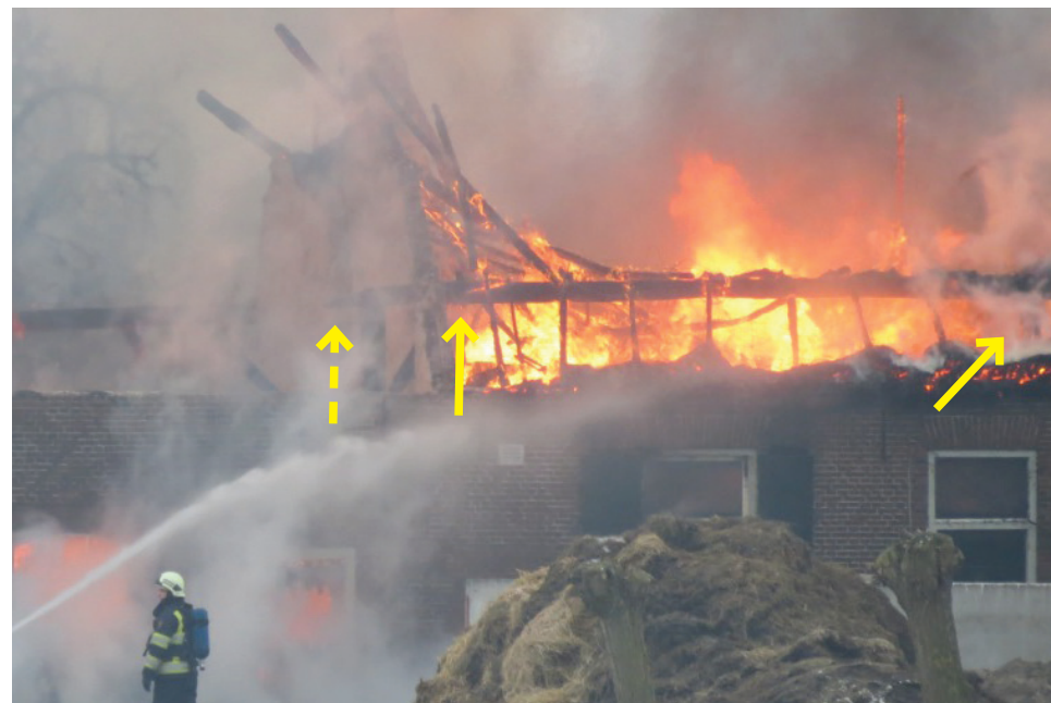
36. De pijl geeft een las met wig aan. Links van de muur een tweede las (gestippelde pijl). Ook is te zien dat de brandmuur tegen het rookkanaal aangebouwd is. De diagonale pijl geeft de gebintstijl in het woonhuis aan. Brabants Centrum, Ad Ligtenberg.
