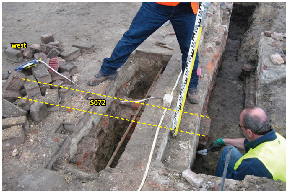
51. De muur haaks op de westmuur die dus deel uit heeft gemaakt van de 'aanbouw'. Hierop is ook te zien dat de westmuur gekromd is. Heemkunde Boxtel 2015.
