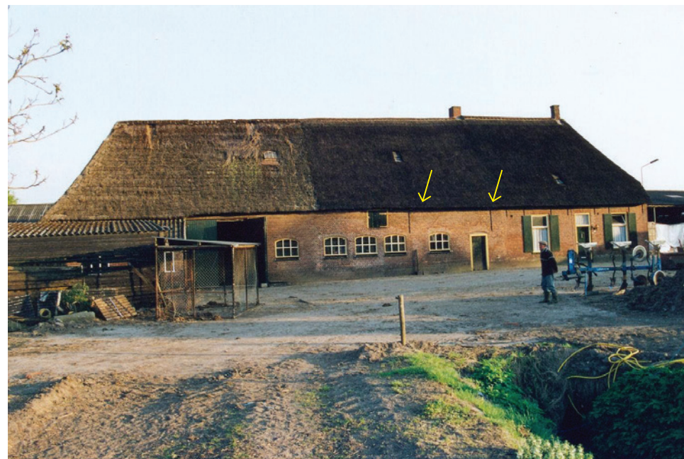
24. Exterieur van de boerderij in 2003. De grote schootankers geven de positie van de gebinten aan. August van Vught heemkundekring
