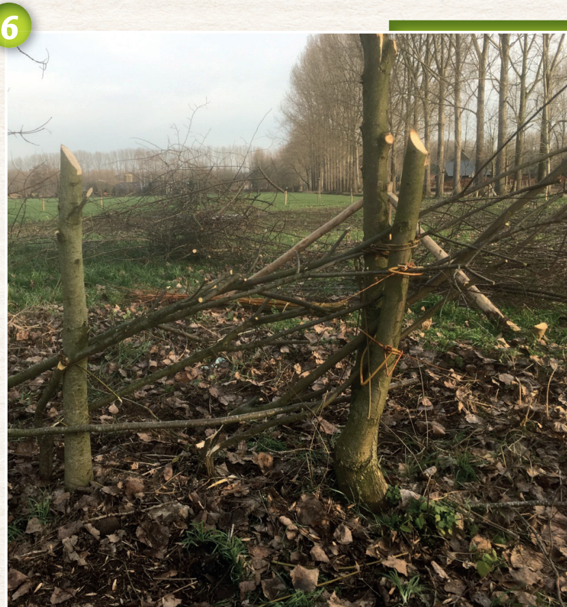
Foto 6 - De staander is schuin afgezaagd op 110-120 cm
